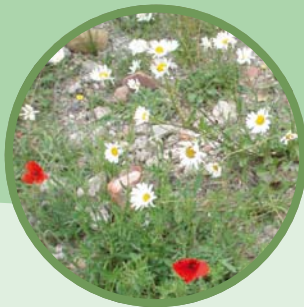
A biodiverse rooftop
